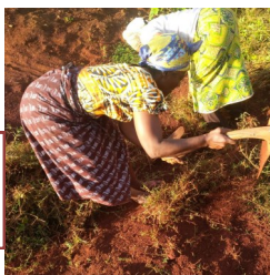
Nettoyage du terrain du chantier de la future église
